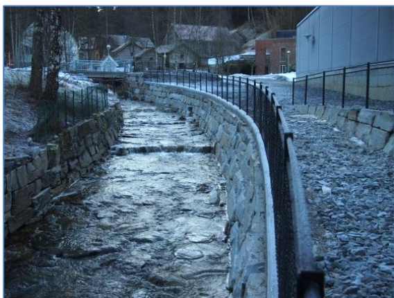
Ny forbygging mot Holvikelva ved Triveselhagen. Foto: Jostein Moldestad.
