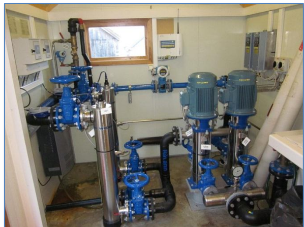
Pumpestasjonen i Reedfjæra som Gloppen kommune tok over då Hovden vassverk vart kommunalt 1. januar 2013. Foto: Ivar Skeistrand.
