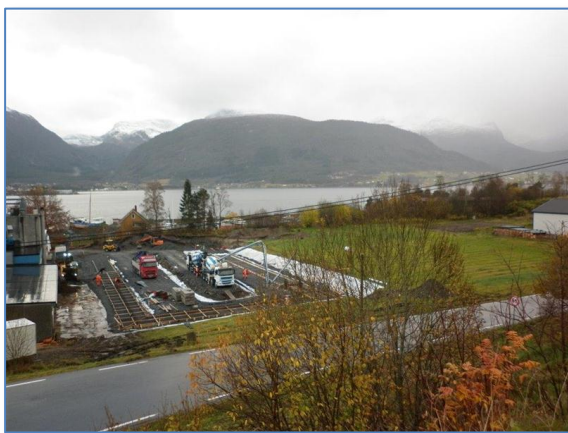
Lagerhallen på Katahamrane som Gloppen kommune har bygt for utleige til Bano AS kom opp på rekordtid i 2013. Her tomte klargjort 1. november 2013. Foto: Odd Arne Kolseth.
