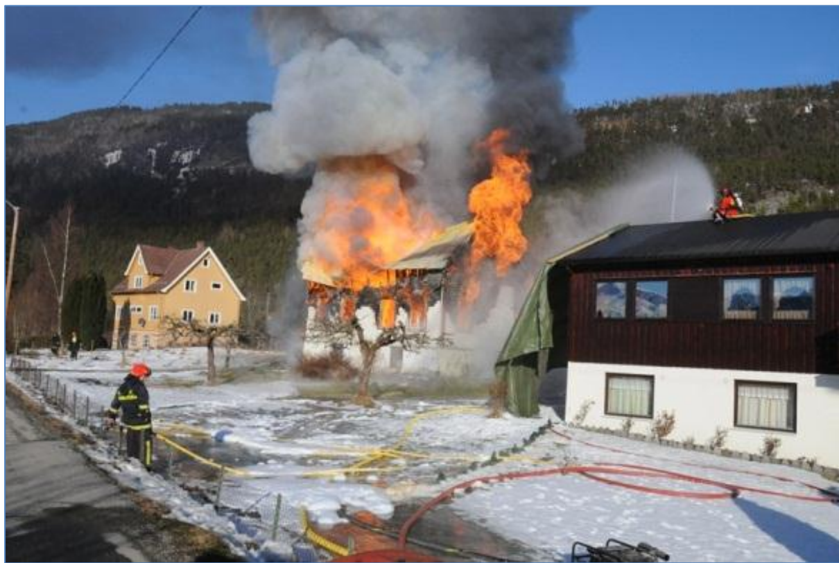
Etter at rivingsløyve var gjeve, vart dette gamle bustadhuset på Kleivedammen «rive» i ei brannøving i februar 2013. Slike realistiske øvingar gjev svær nyttig kunnskap til brannmannskapet. Foto: Jan Nik. Hansen, Firda Tidend.
